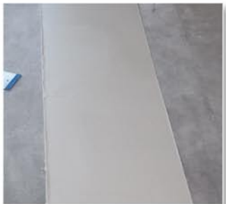
Nach 1-2 Stunden ist die Masse ausgehärtet und kann geschliffen und versiegelt werden.
