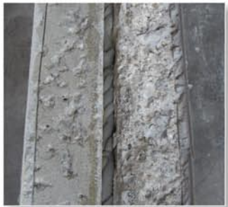
Der beschädigte Boden wurde eingeschnitten und entfernt.
