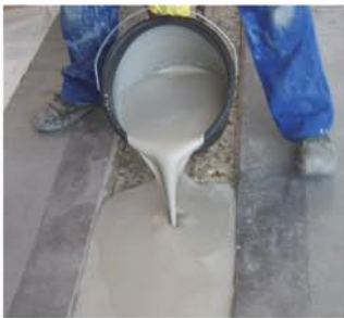
Die Spezial-Kunstharzmischung wird in den vorbereiteten Streifen gegossen.
